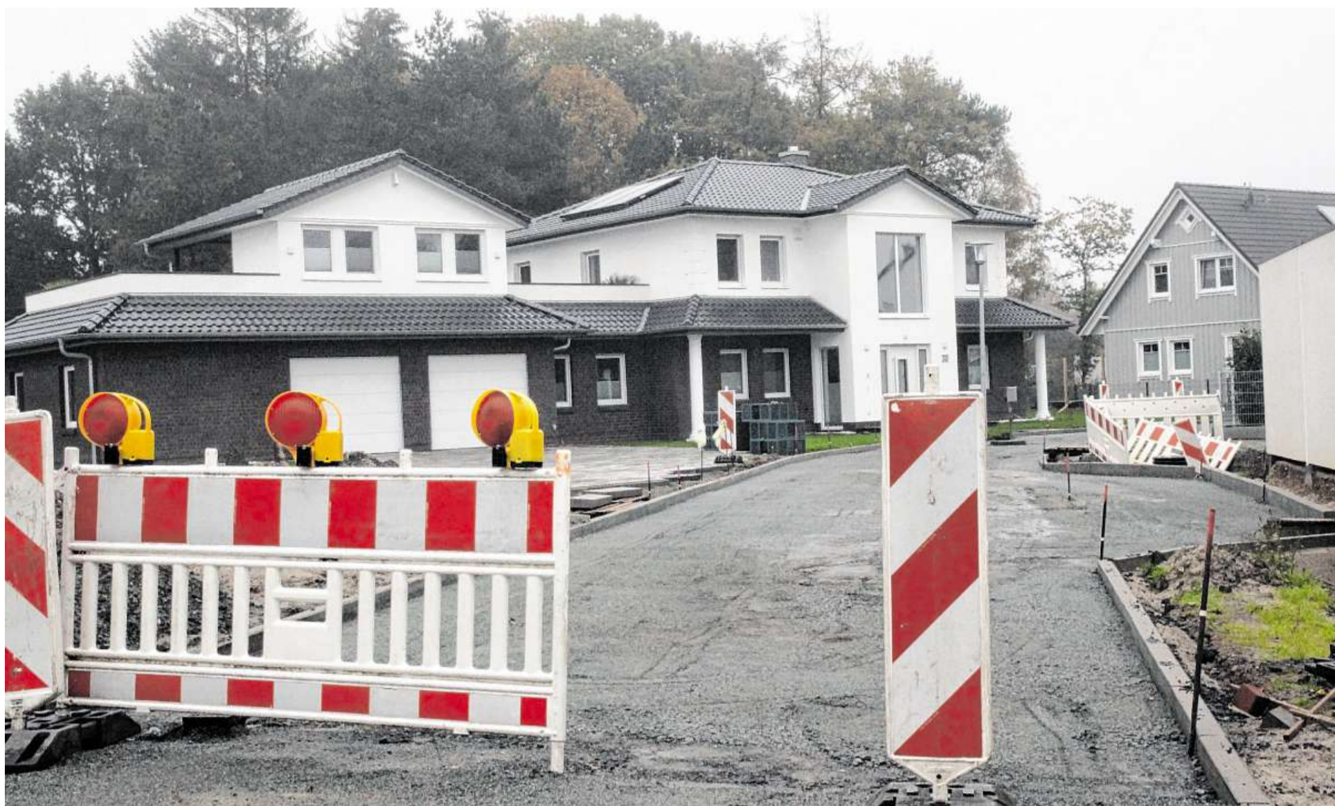
Alle 50 Rohbauten sind bis Jahresende fertig geworden. Pflasterung, Begrünung und Beleuchtung sollen bis Anfang nächsten Jahres folgen.
