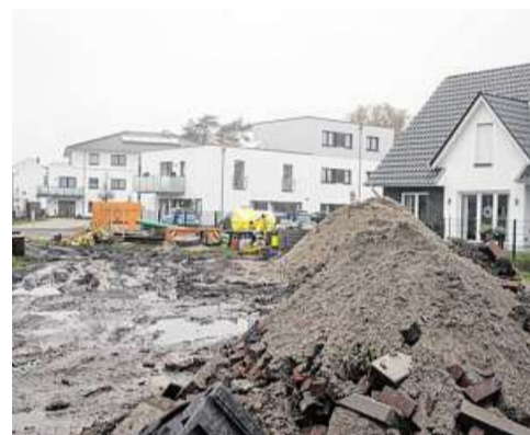
Im Vordergrund soll ein Spielplatz entstehen, dahinter liegt die Seniorenwohnanlage.
